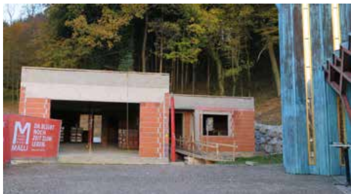
Neubau des Pfarrzentrums in Thal: Herzlichen Dank an die Firmen Malli und Mandlbauer und unseren Bauausschuss mit Rudi Petrik, Josef Wetzlberger und Andreas Maier.
